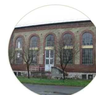
3 Elektromos elosztó épület
